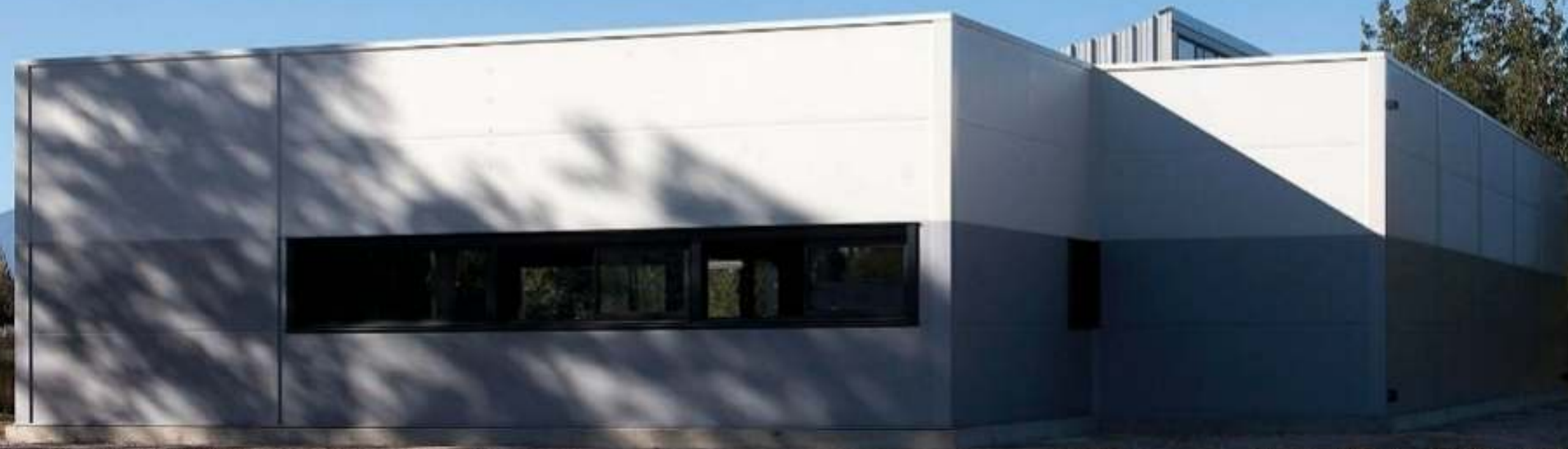
PYRESCOM - Laboratoire pharmaceutique à CANOHES
